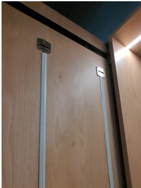
柜门拉直器安装效果图
